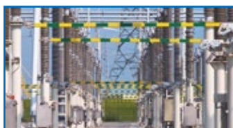
Levé sur les lignes électriques
