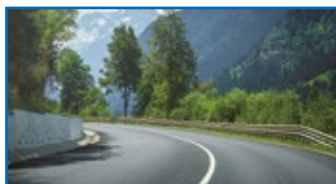
Levé sur les autoroutes
