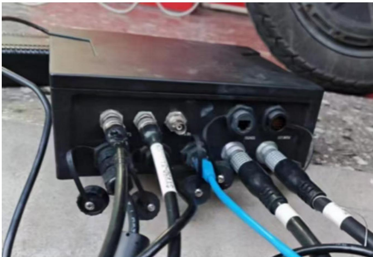
Figure 2-7 Installation de l'unité de pont
