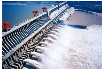
Mesure du barrage
